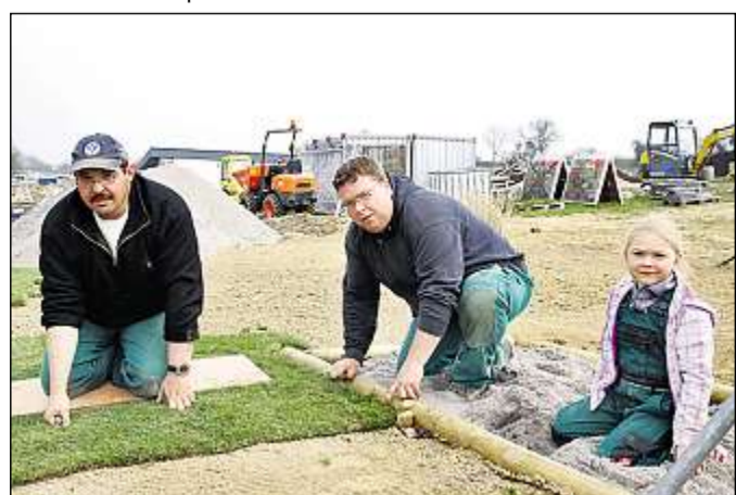
Arbeiten an den Außenanlagen laufen unterstützt durch Georg Wolfs Enkelin Alina. Foto: apo
